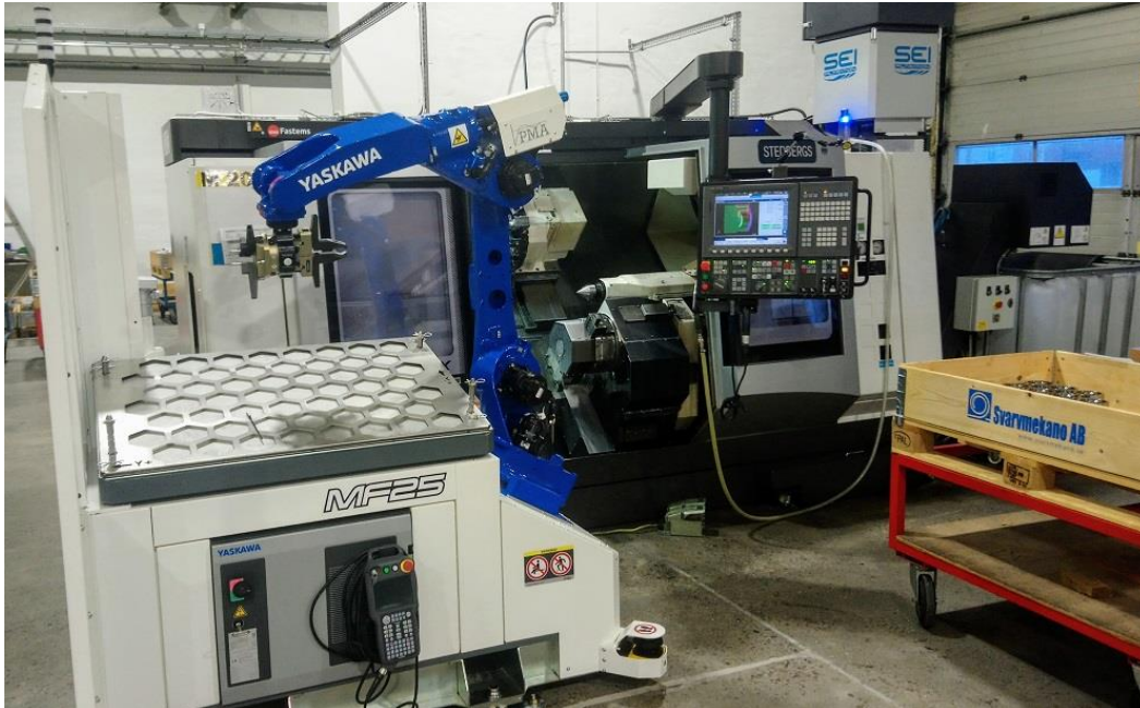
Precis nyanländ robotcell under installation på Svarmekano.
